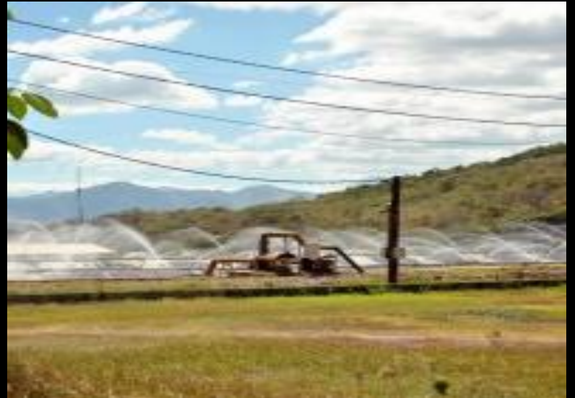
Tratamiento del agua de la mina
